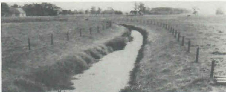
Ausgebauter Axtbach bei Hemfeld 1959: Schuttablageplatz, Abwasserzulauf, bewirtschaftet bis an die Uferkronen - kein Baum, kein Strauch.
