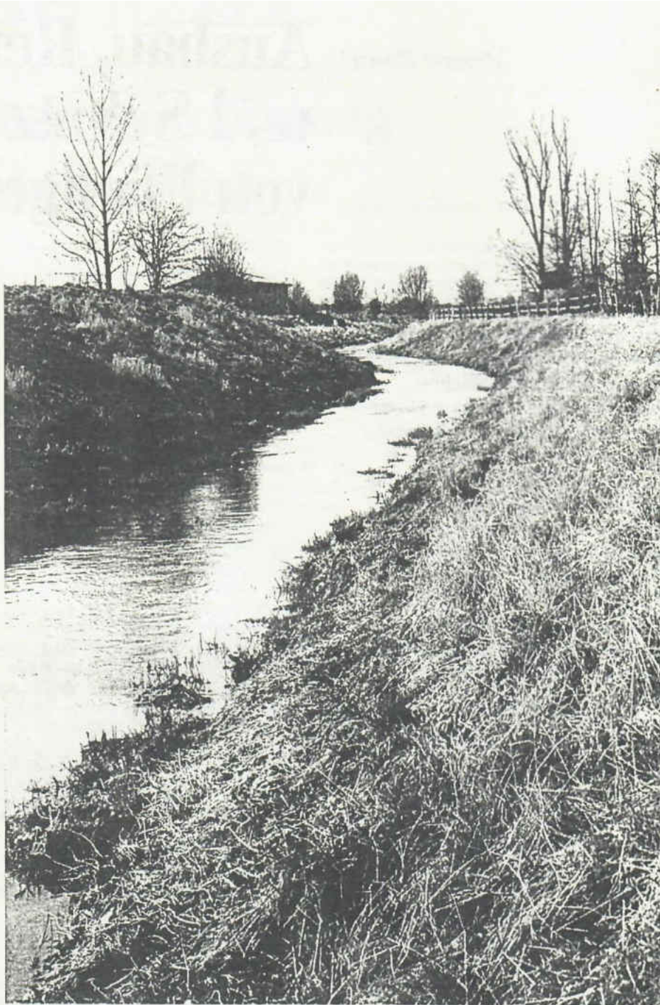
Abb. 1: Konventionell ausgebauter Flachlandbach etwa 20 Jahre nach der Maßnahme
