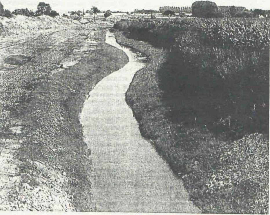
Abb. 3: „Naturnah“ genannter Bachausbau aus dem Jahr 1986 Aus der Sicht des Naturschutzes sind vor allem die fehlende Variation des Mittelwasserbettes und der Ufer und die landwirtschaftliche Nutzung bis zur Böschungskrone zu bemängeln
